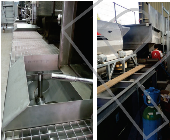
Vor Ort Montage flexibel, schnell, sicher
